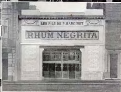
Façade, quai des Chartrons, 136.
